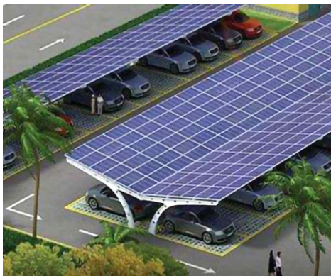
停车场分布式光伏电站
